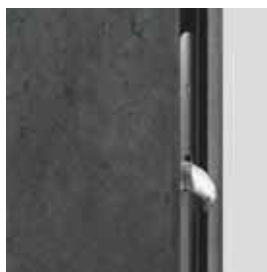
2 háky proti vylomeniu protipožiarne tesnenie (Typ II)
