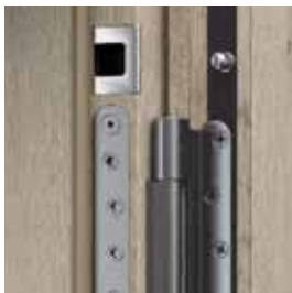
4 bezpečnostné trne proti vysadeniu protipožiarné tesnenie (Typ II)
